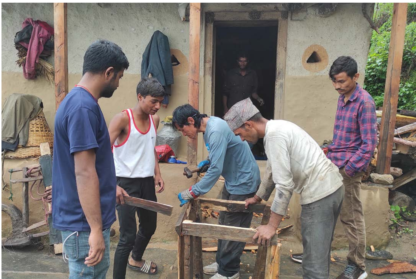
Vorbereitungen bei der Ofeninstallation.
