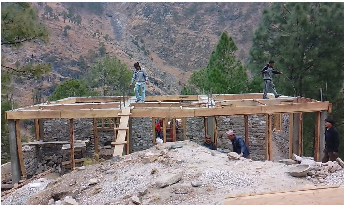
Der Rohbau des Jugendzentrums im Februar.
